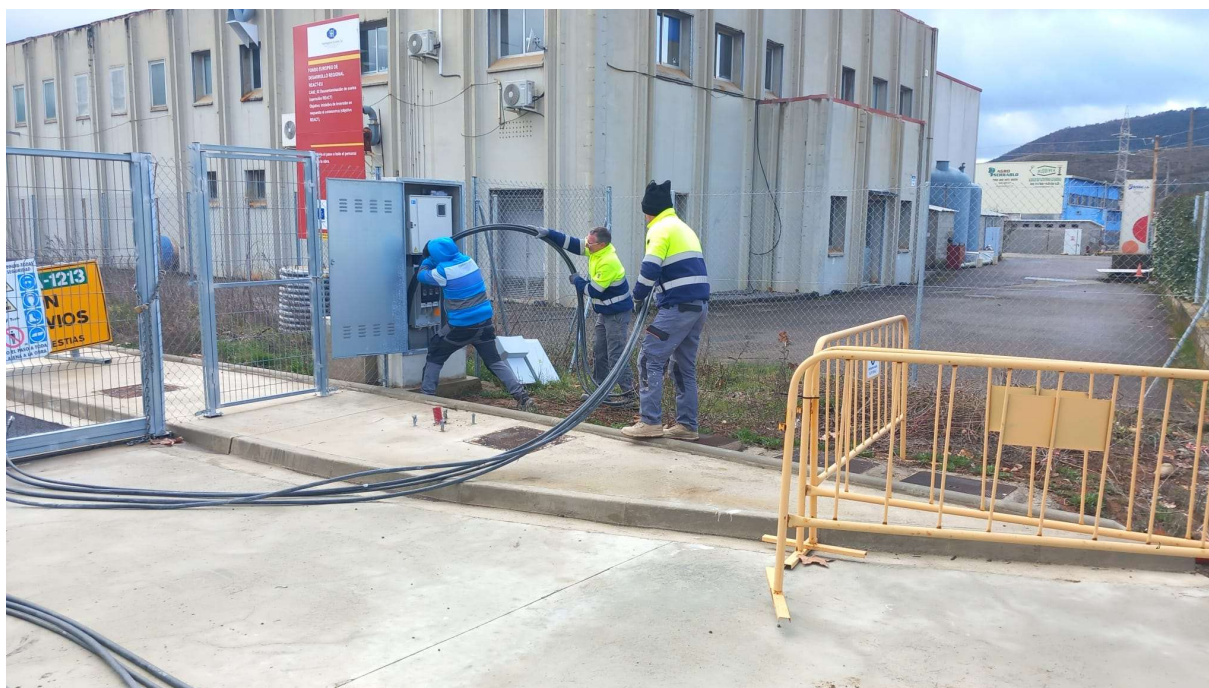
Fotos. Tendido cable desde la hornacina instalada hasta punto de conexión.
