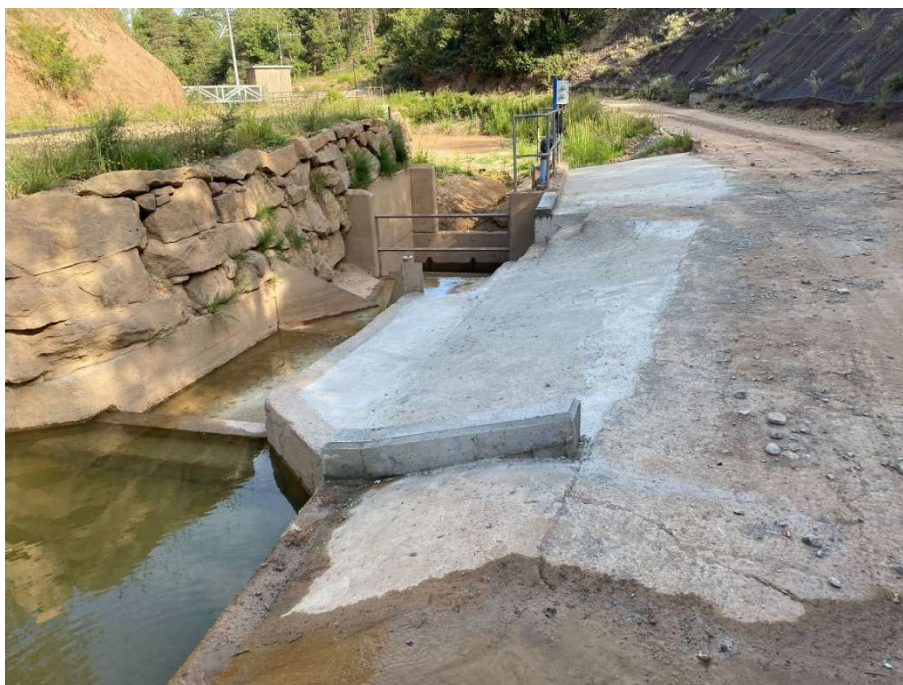
Foto. Arreglo zona perimetral desarenador y pozo de captación. Estado final.
