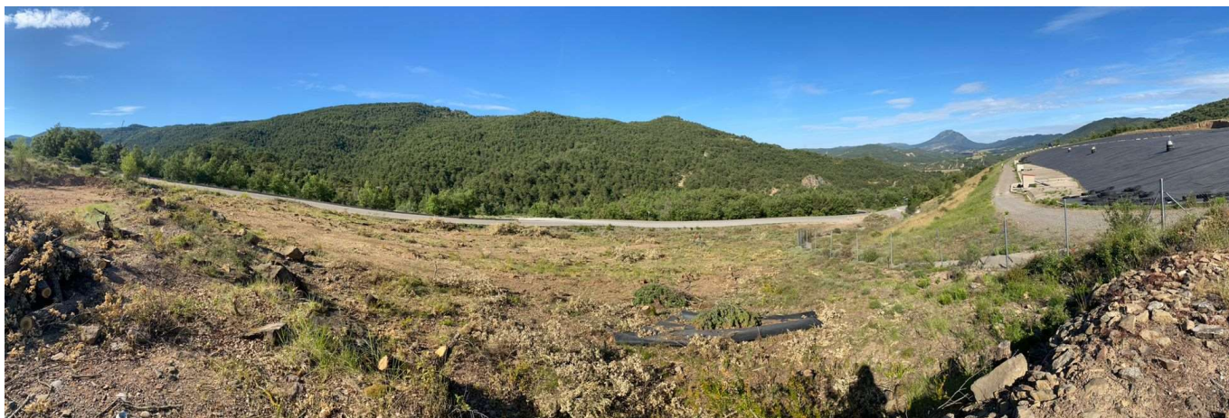
Foto. Eliminación arbolado sureste nueva celda. Panorámica.
