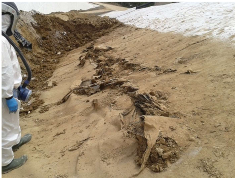
Foto. Rotura paquete de impermeabilización, año 2014.
