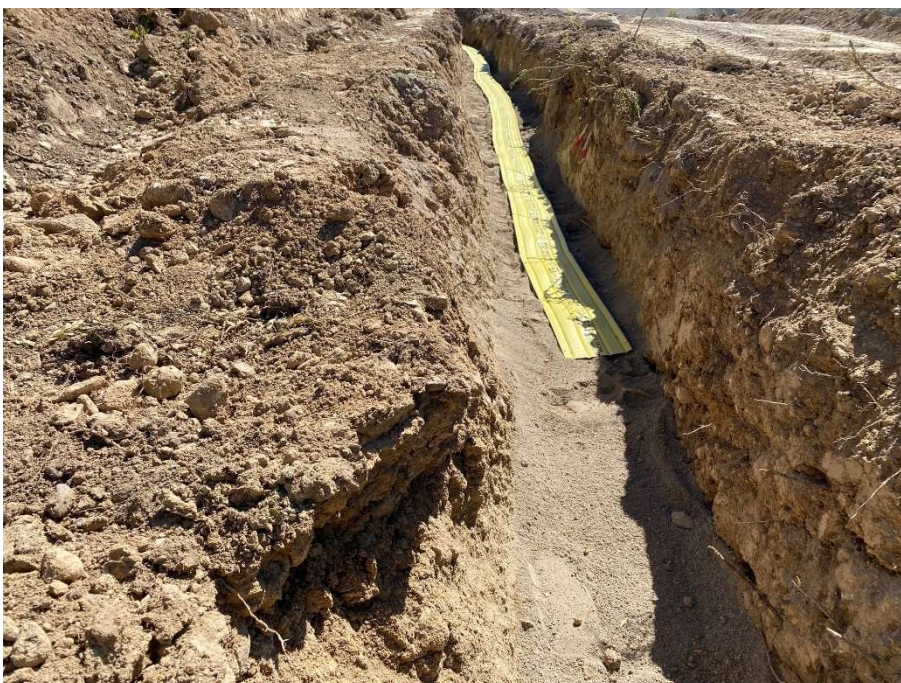
Fotos. Relleno con arena y señalización zanja.
