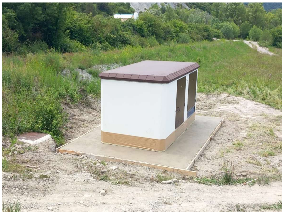
Fotos. Acera perimetral CT.
