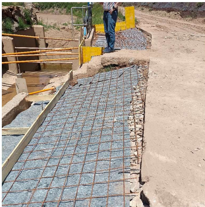
Foto. Arreglo zona perimetral desarenador y pozo de captación 05/06/2024.
