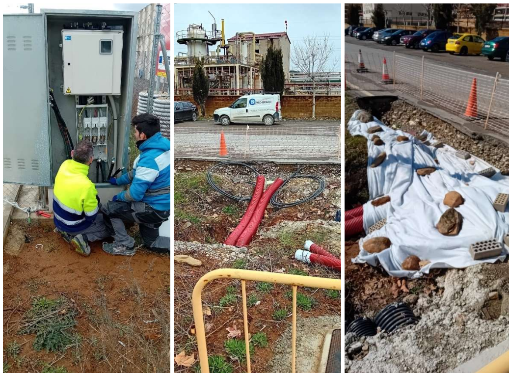
Fotos. Zanja y cable desde la hornacina instalada hasta punto de conexión.
