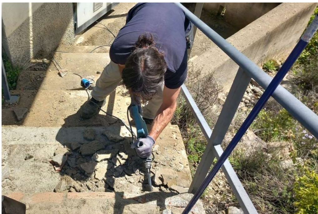
Foto. Arreglo escalera de acceso a RG05.
