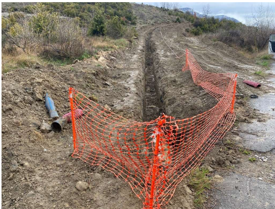
Fotos. Apertura de zanja del nuevo trazado modificado.
