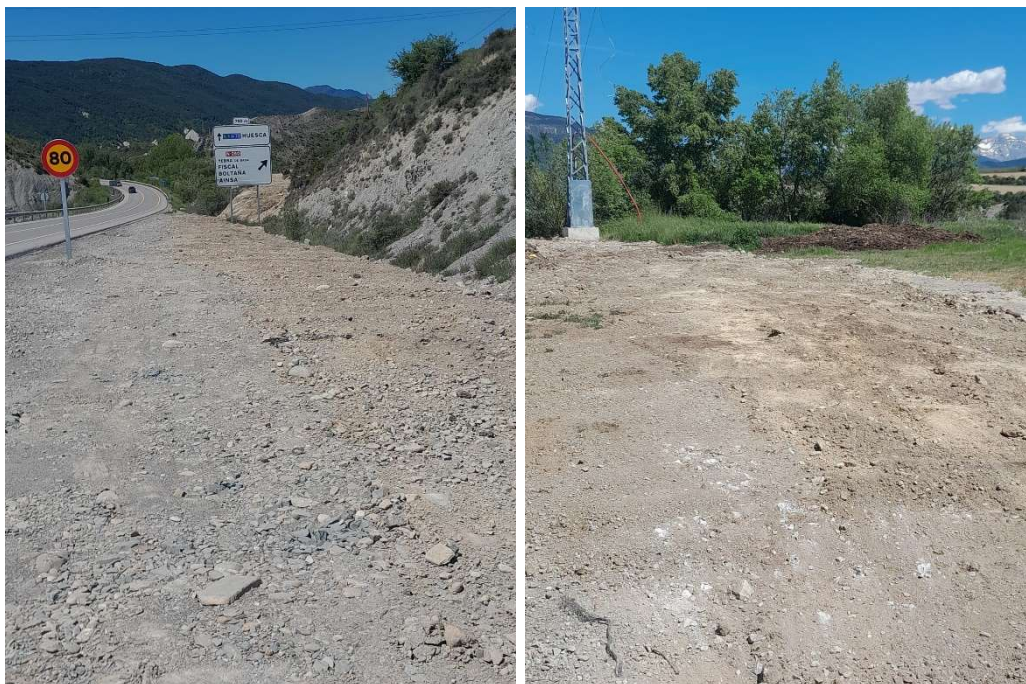
Fotos. Relleno zanja y terraplenado.
