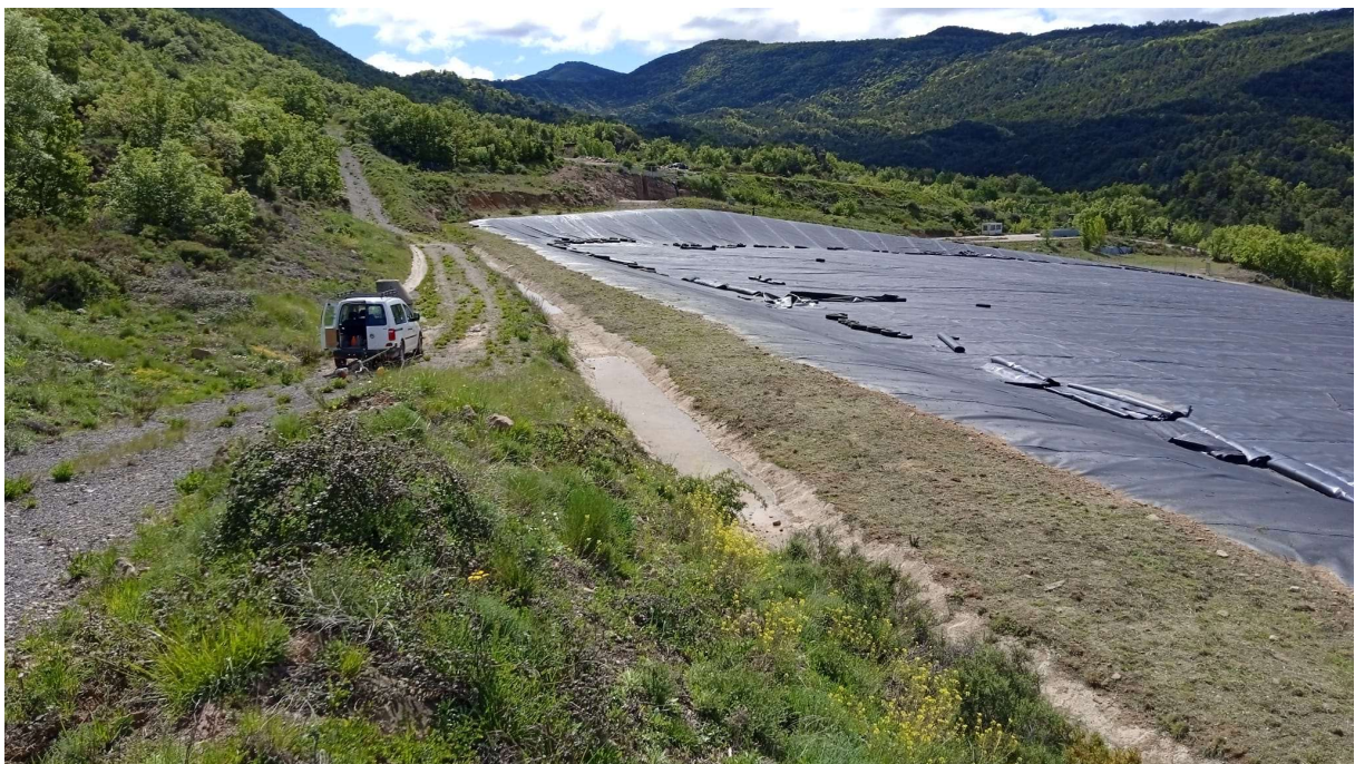
Foto. Desbroce talud nueva celda Bailín.
