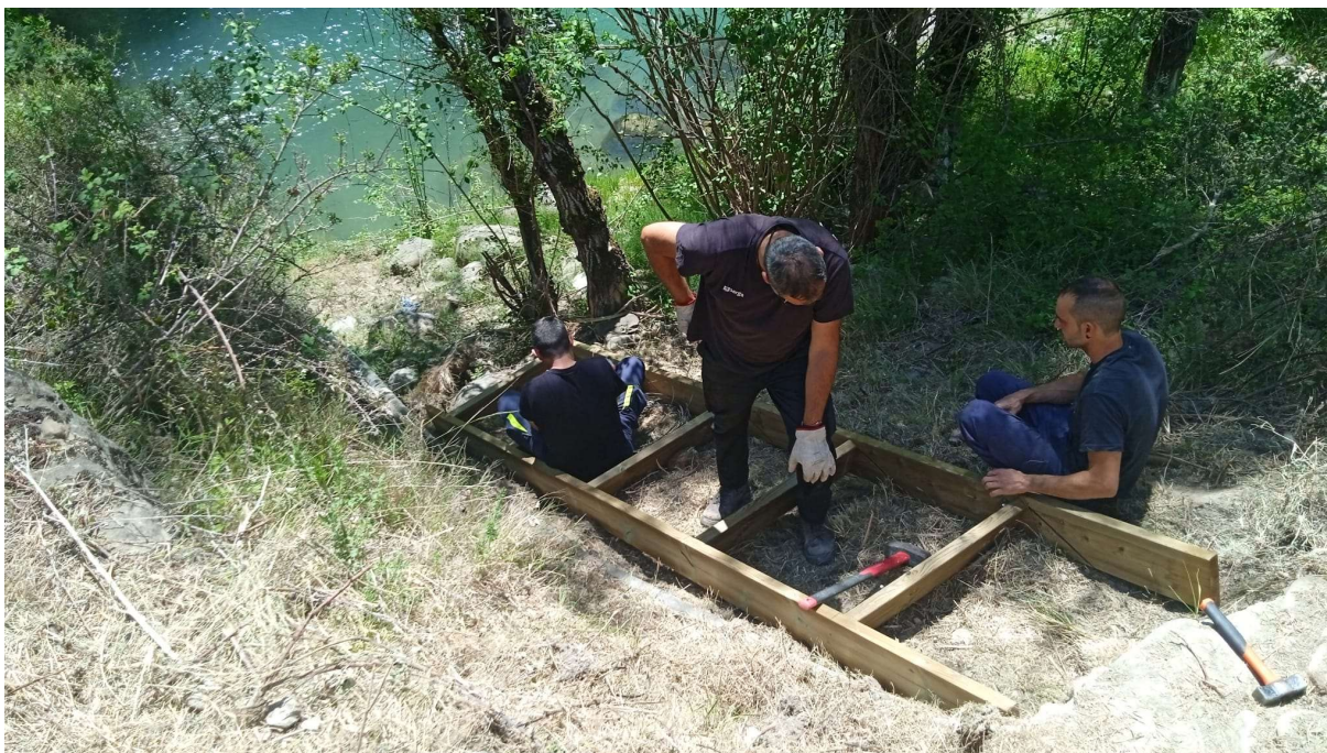
Foto. Escaleras de acceso a río Gállego desde RG05.
