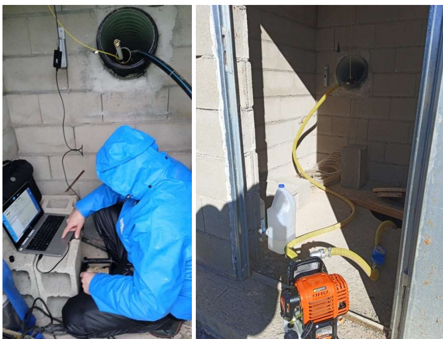
Foto. Trabajos de descarga de datos y bombeo de pozos de goteo.
