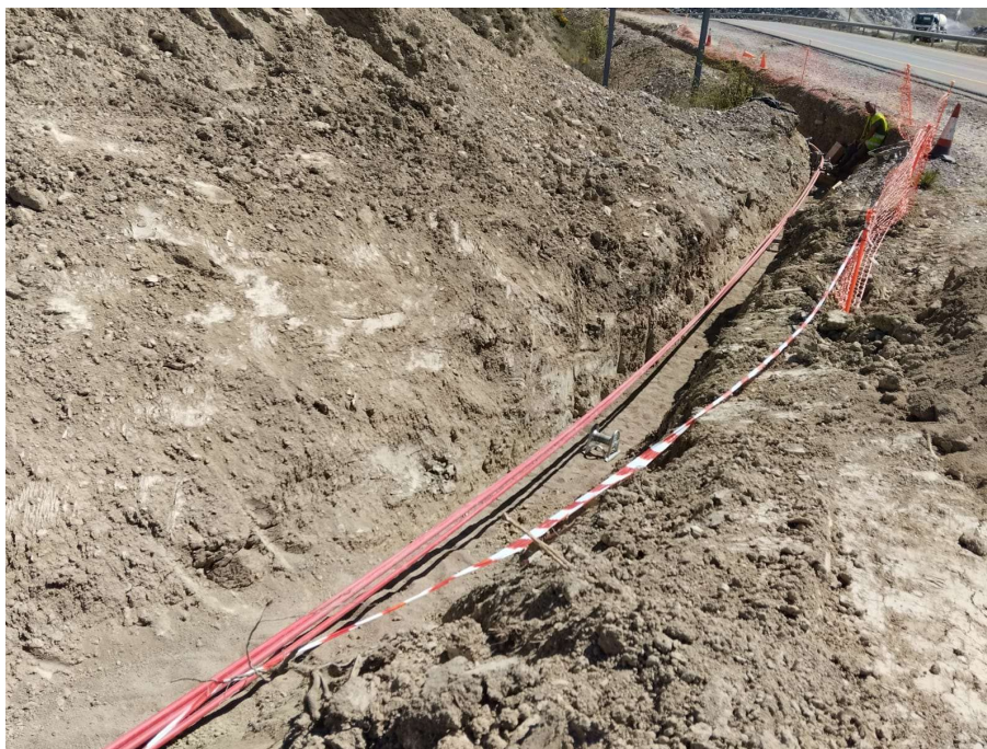
Fotos. Tendido de cable sobre cama de arena.
