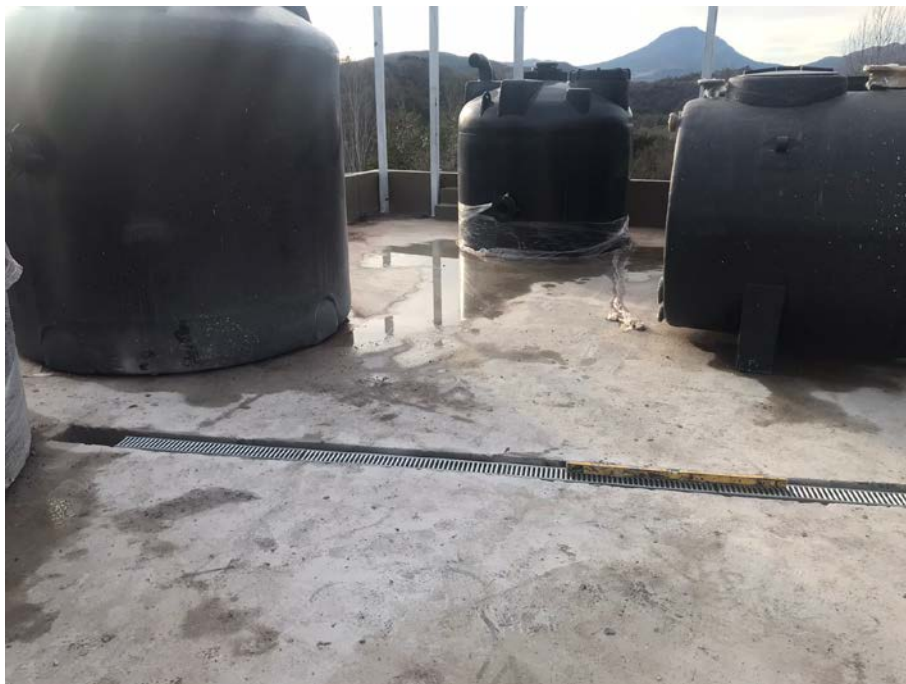
Foto. Canaleta de drenaje plataforma inferior LIFE.
