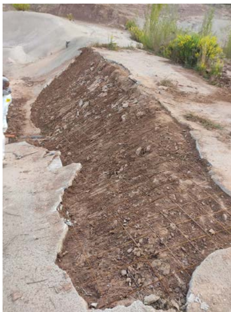
Foto. Reparación dique balsas gunitadas.
