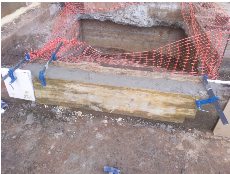
Foto. Reparación muro perimetral depósito enterrado en Inquinosa.
